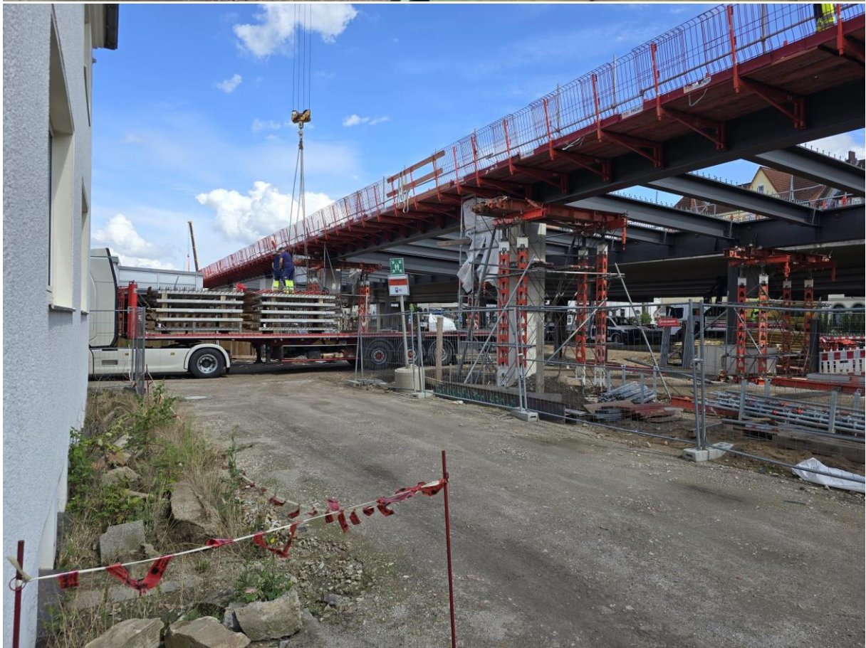
Stand der Arbeiten 04.07.2024
